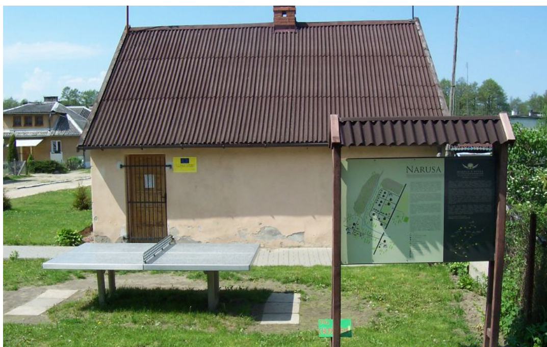
Świetlica wiejska w Narusie
